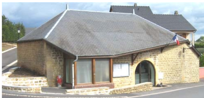
La Mairie en 2006 après démolition de la maison Saint Mard et l'ouverture de la Rue du Lavoir
